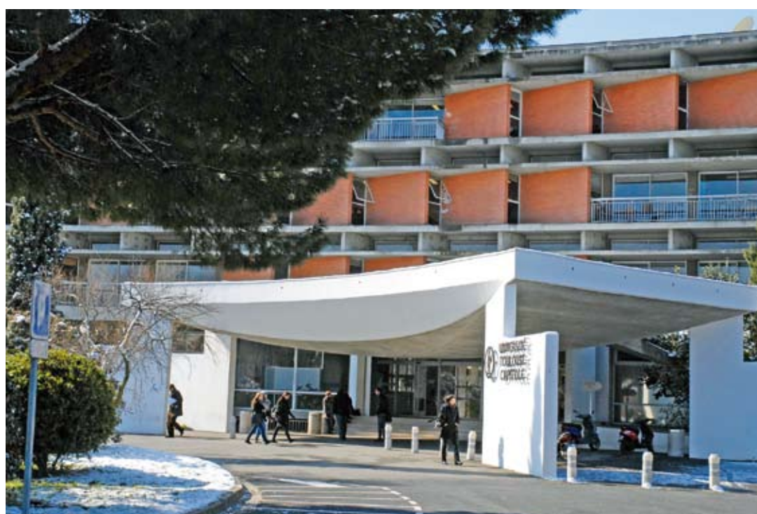
L'entrée principale d'UT1 Capitoile (bâtiment Arsenal).
