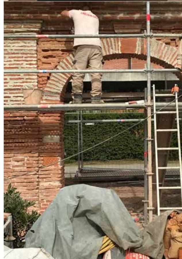
La maçonnerie des piliers a été dégagée et consolidée. Les emplacements de deux piliers disparus au bout de la travée Nord ont été matérialisés au sol par la pose d'éléments en terre cuite au milieu du dallage en pierres.
